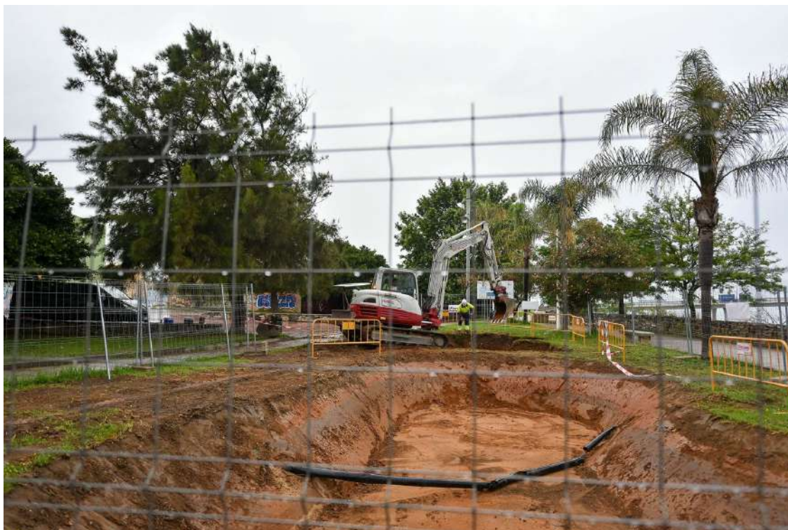
Obras de Emalgesa en el paseo de los Cornisa.
