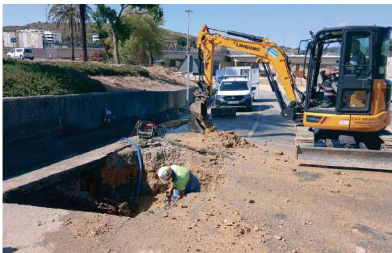
Obras en la red de la zona sur de Algeciras. VIVA CG
