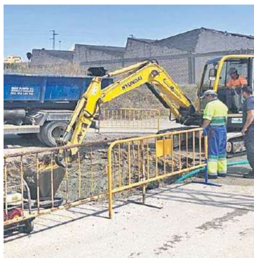
Operarios de Emalgesa reparan la avería.
