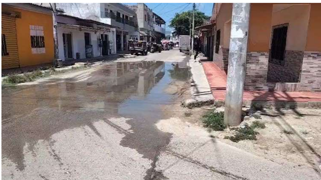
En la zona comercial también se rebosan los manjoles.
